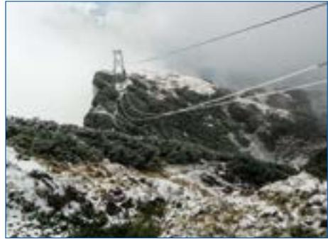
*Schneelast sorgt für Seilrisse am Zugseil*
